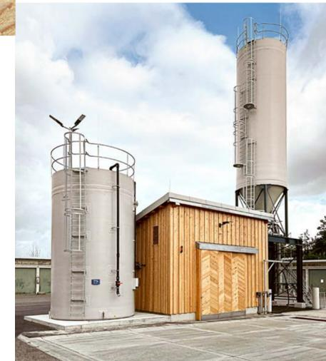
↑ L'installation à saumure à Mayence avec un équipement raffiné: notre propre développement Quanto 24 mélange la solution saline et une unité centrale permet de commander et surveiller l'installation par pression sur un bouton.
