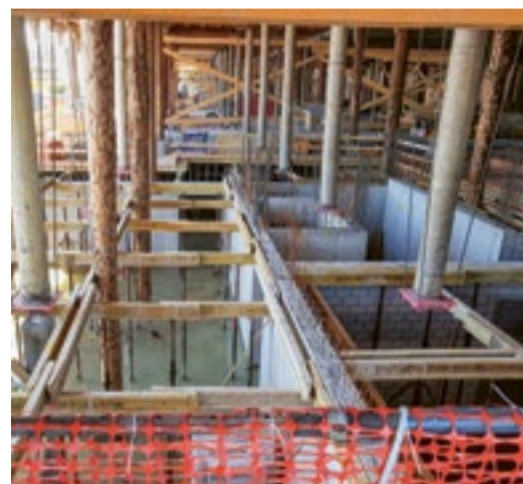
Pendant la transformation, la Kornhaus a été entièrement désossée. Près de 80 troncs d'arbres ont supporté la charge du bâtiment pendant la première phase de la rénovation.
