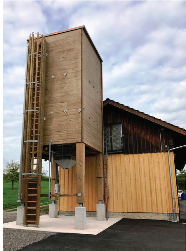
Salzsilos E4 in Plattenbauweise mit BSH-Stützen und diversen Zusatzelementen:
