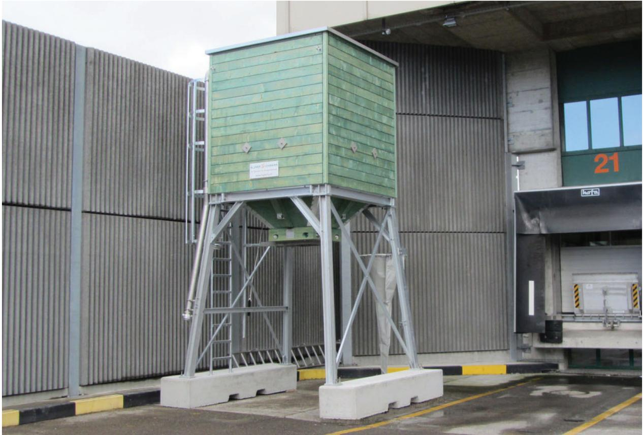
Das Kleinsilo für Splitt oder Salz kann aufgrund der einfachen mobilen Beton-Fundamente flexibel eingesetzt werden.
