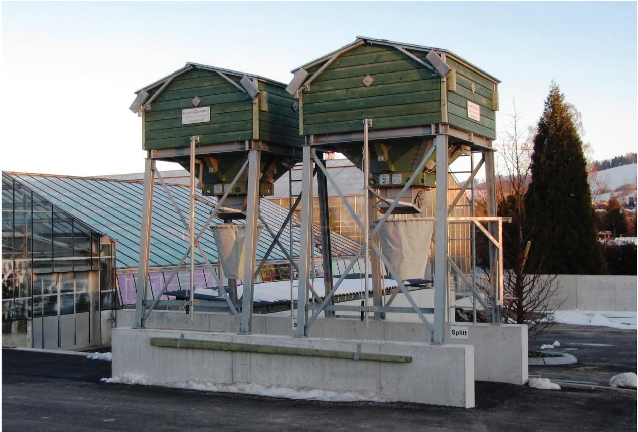
Kleinsilos auf feuerverzinktem Stahlunterbau
