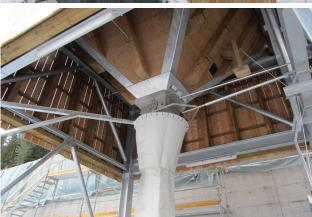
Die Streugutsilos in Modulbauweise wurden auf einem feuerverzinkten Stahlunterbau erstellt.
