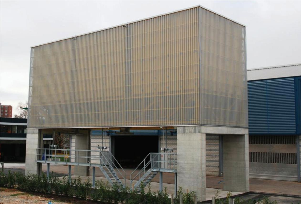
Dieser Salzsilo in Modulbauweise wurde auf dem Werkhof im Stadtgebiet Aarau und Lenzburg errichtet. Die Anlage besteht aus 3 Silos mit durchgehender Fassade.
