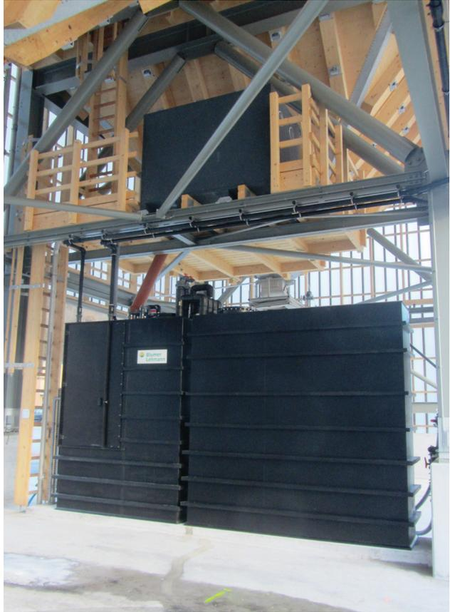
Doppelmodul-Siloanlage mit spezieller Holz-Poly-carbonat-Fassade in der Optik einer Boden-Deckel-Schalung.
