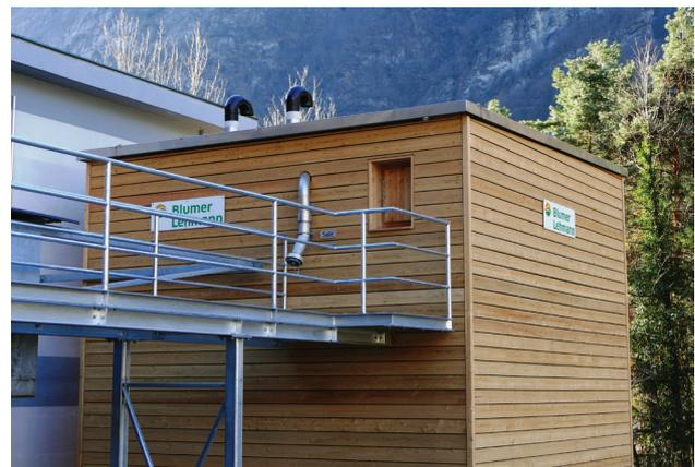
Diese Modulsiloanlage mit offener Lärchenschalung ist auf einem feuerverzinkten, duplexierten Stahlunterbau erstellt.
