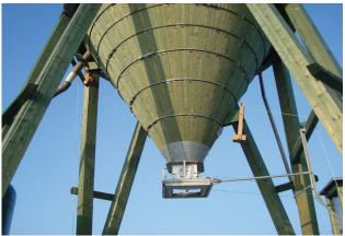
Die Silos sind mit Bedienpodest, einschwenkbarem Windsack und manueller Füllstandsmessung ausgestattet
