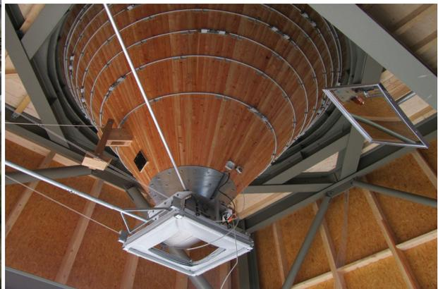
Diese 3 x 300 m<sup>3</sup> Siloanlage wurde so konstruiert, dass sie in den angrenzenden Werkhof integriert werden konnte. Die Silos und die Fassade des Werkhofes sind aus heimischer Lärche gefertigt. Die Durchfahrt ist 7 m breit, damit sich LKWs kreuzen können. Die ganze Anlage wird mit Dehnmessstreifen verwogen und ist zur Entnahmeanalyse an den Salzmanager angebunden.
