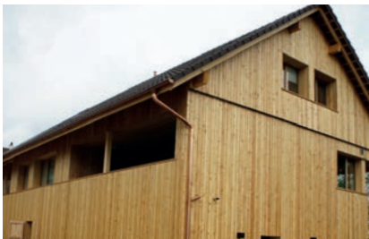
Fassade Gebirgsklärche (Ausführung Mannhart Holzbau AG)
