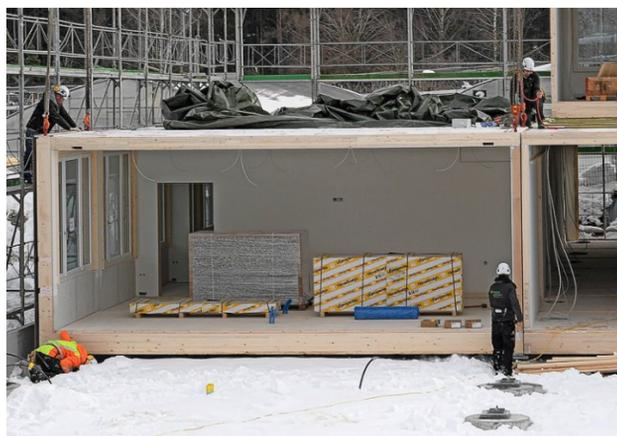
Die vorgefertigten Holzmodule wiegen bis zu zehn Tonnen.
