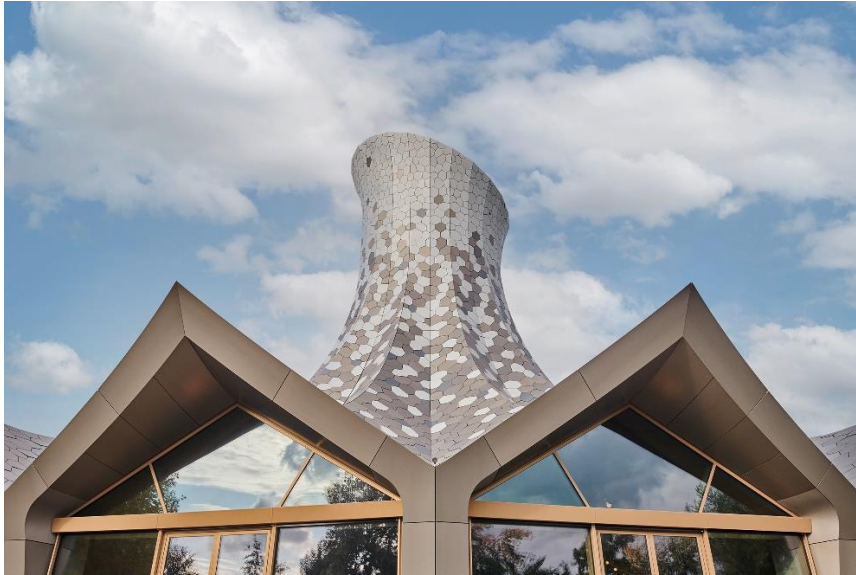
Der 26 m hohe Turm aus einer geschwungenen Holztragkonstruktion ist der Blickfang des Gebäudes. Foto: Luca Zanier
