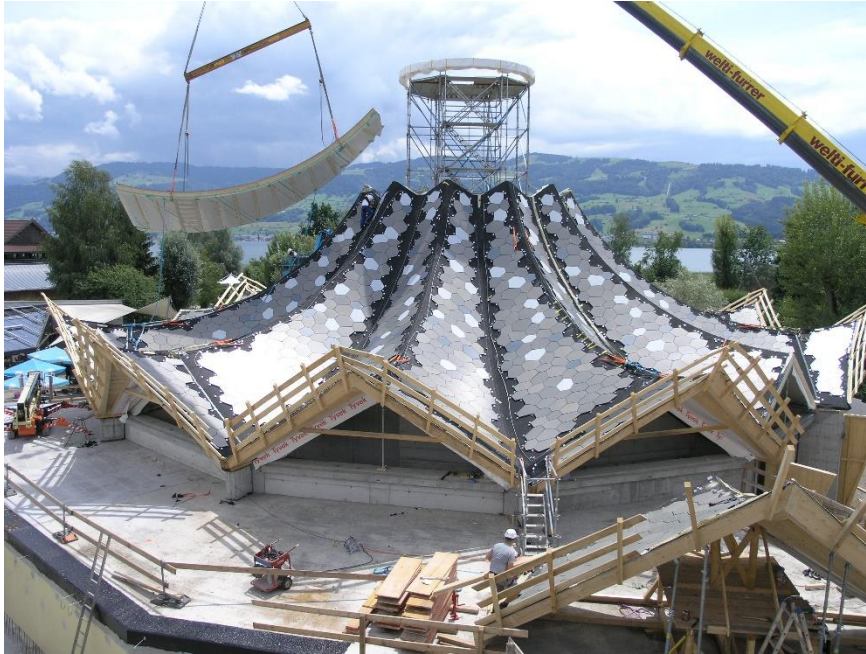
24 Elemente mit je 4 Tonnen Gewicht wurden so montiert, dass sie ein Faltragwerk bilden. Foto: Blumer-Lehmann AG
