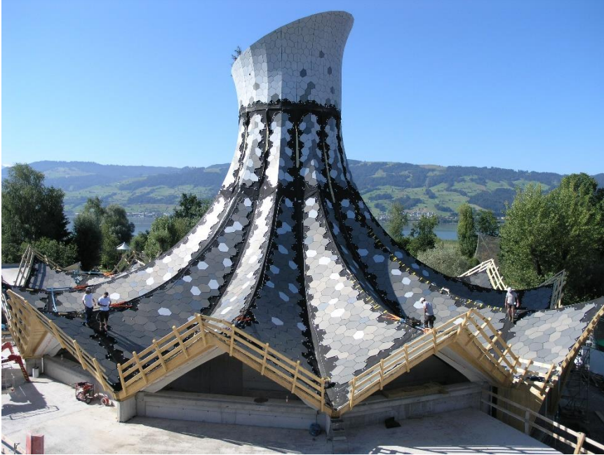
Das freitragende Dach wird von unregelmäßig geformten Blechschuppen bedeckt. Foto: Blumer-Lehmann AG
