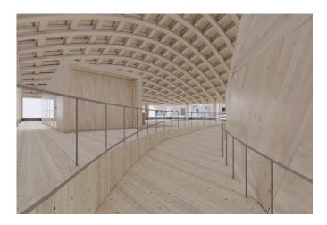
Das Main Roof besteht aus einer FreeForm-Konstruktion, die eine Grundfläche von 25 x 48 Metern überspannt. Zusammen mit ihren Partnern übernahmen die Freiform-Spezialisten von Blumer Lehmann Planung, Produktion und Ausführung der hochkomplexen Dachgeometrie.
