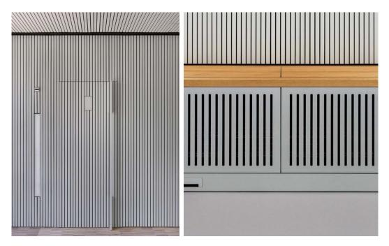
Für die Wandverkleidung wurde das Tannenholz stark deckend grau lasiert. Die 32 Millimeter breite Holzschalung wurde vertikal montiert, die acht Millimeter breiten Fugen sind durch eine schwarze Folie blickdicht hinterlegt.
