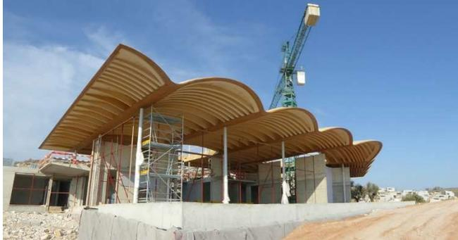
**Die Wellenberge werden aus 187 Sekundärbalken geformt. Das Standardmaß für die Bogenbinder ist 120/500 Millimeter, wobei die Maße abhängig von den statischen Anforderungen und der Menge der Sonderausschnitte stark variieren.**
