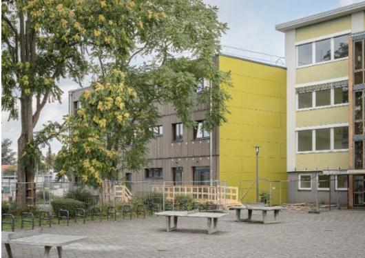
Durch die Holzmodulbauweise besteht der Erweiterungsbau zu einem großen Teil aus nachwachsenden Baustoffen.
