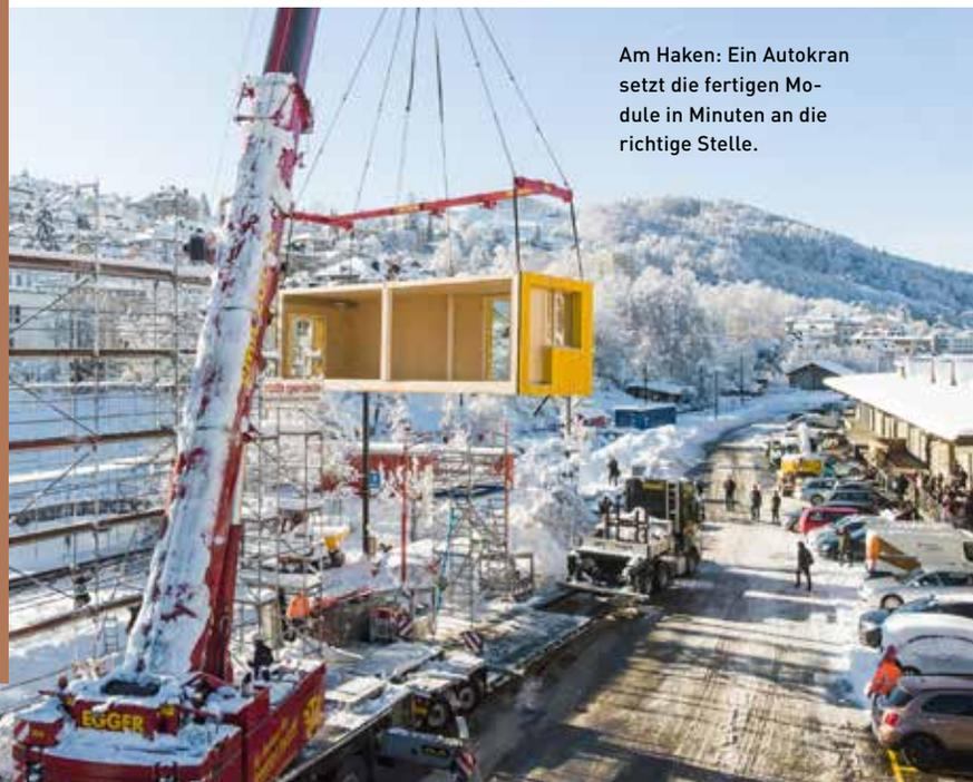
Am Haken: Ein Autokran setzt die fertigen Module in Minuten an die richtige Stelle.
