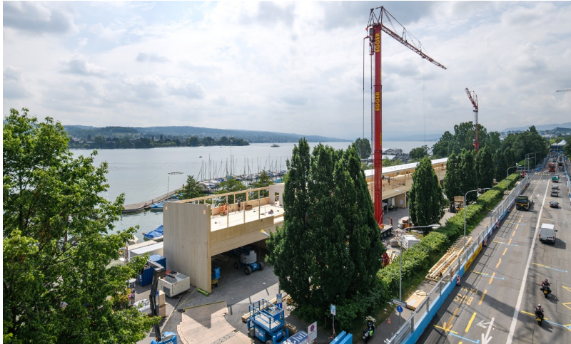
Aufbau temporäre Boxengasse
