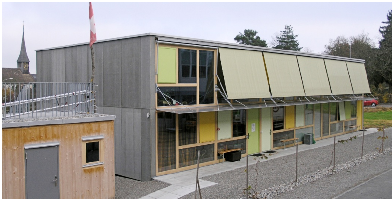
Grossflächige Fensterfronten mit Beschattungssystem
