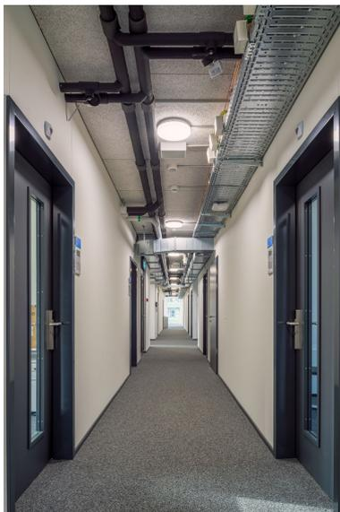
Auf Wunsch der Bauherrin wurden für den einfachen Zugang die Installationen in den Korridoren sichtbar installiert.
