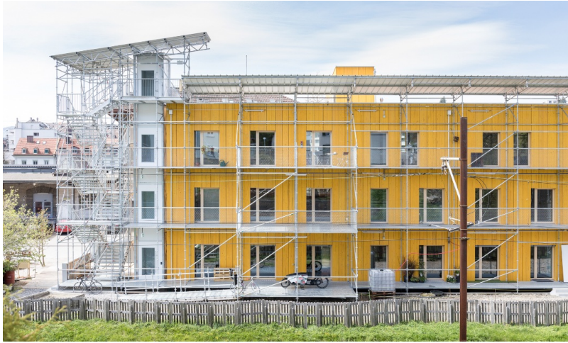
Accès par la pergola externe
